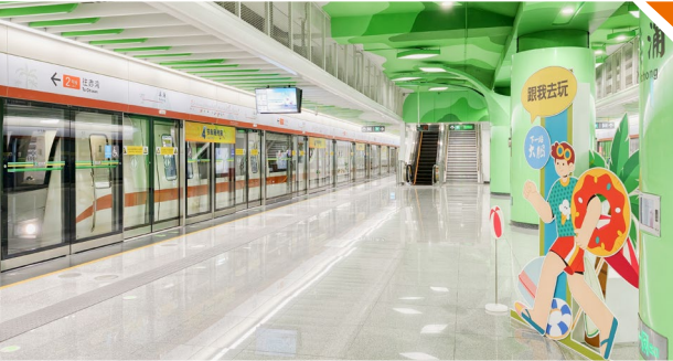
深铁集团 2025 年新开通 8 号线三期溪涌站
