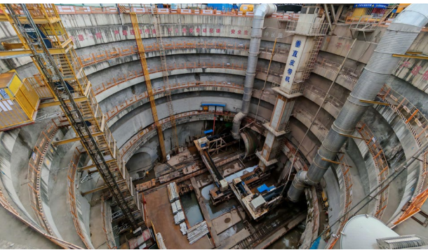
深铁集团所属深惠城际大鹏支线盾构施工现场
