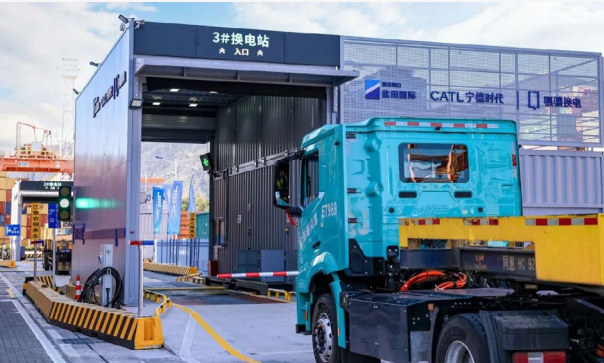
盐田港区换电站
