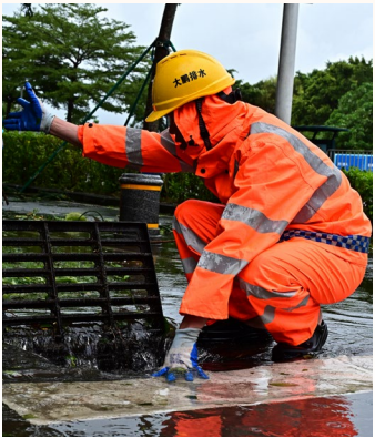
深圳环水集团高效疏通市政主干道排水管网设施
