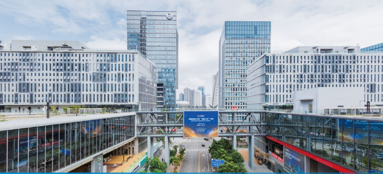
深圳市软件产业基地
