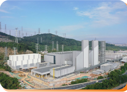
深圳能源集团光明燃机电厂
