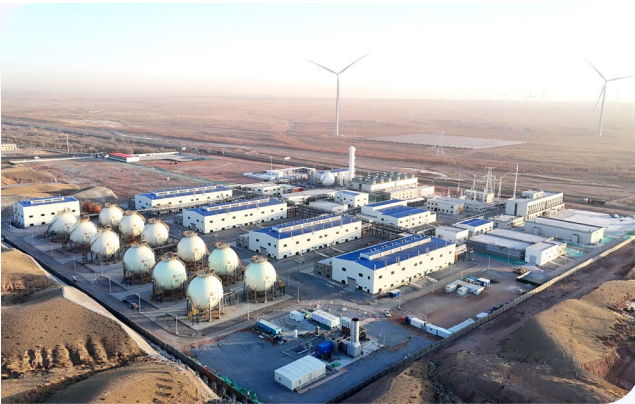
深圳能源集团鄂托克旗风光制氢一体化合成绿氨项目是集风力发电、电解水制氢、绿氢合成绿氨、离网型光伏制氢、30 兆瓦纯氢燃气轮机和综合储能系统为一体的绿色能源化工项目
