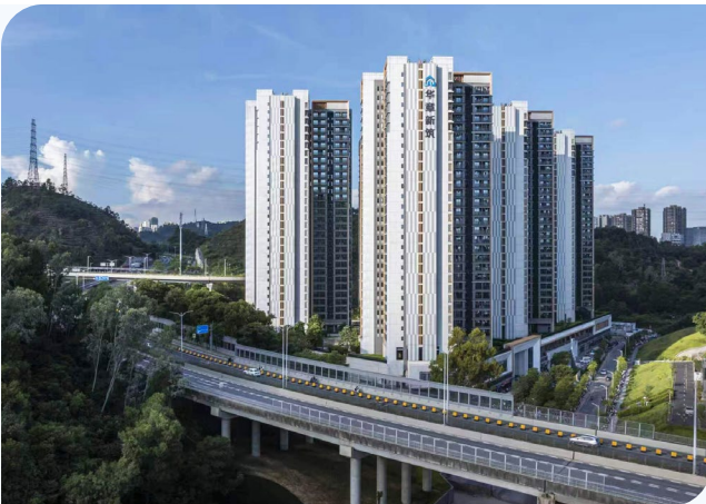
国内首个百米高度的混凝土模块化高层住宅——“华章新筑”项目
