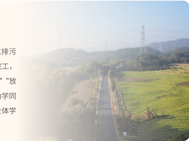
特区建工集团承建的“深汕大中修”工程基本完工，涵盖 15 段“四好农村路”项目道路维修
