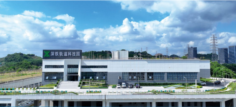
深铁轨道交通科技园（凉帽山园区）
